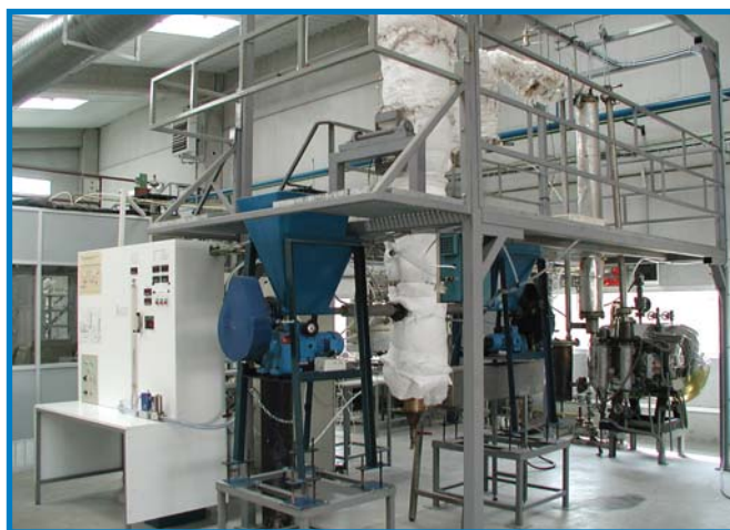
Planta piloto de combustión/gasificación en lecho fluidizado Fluidised bed combustion/gasification pilot plant.
